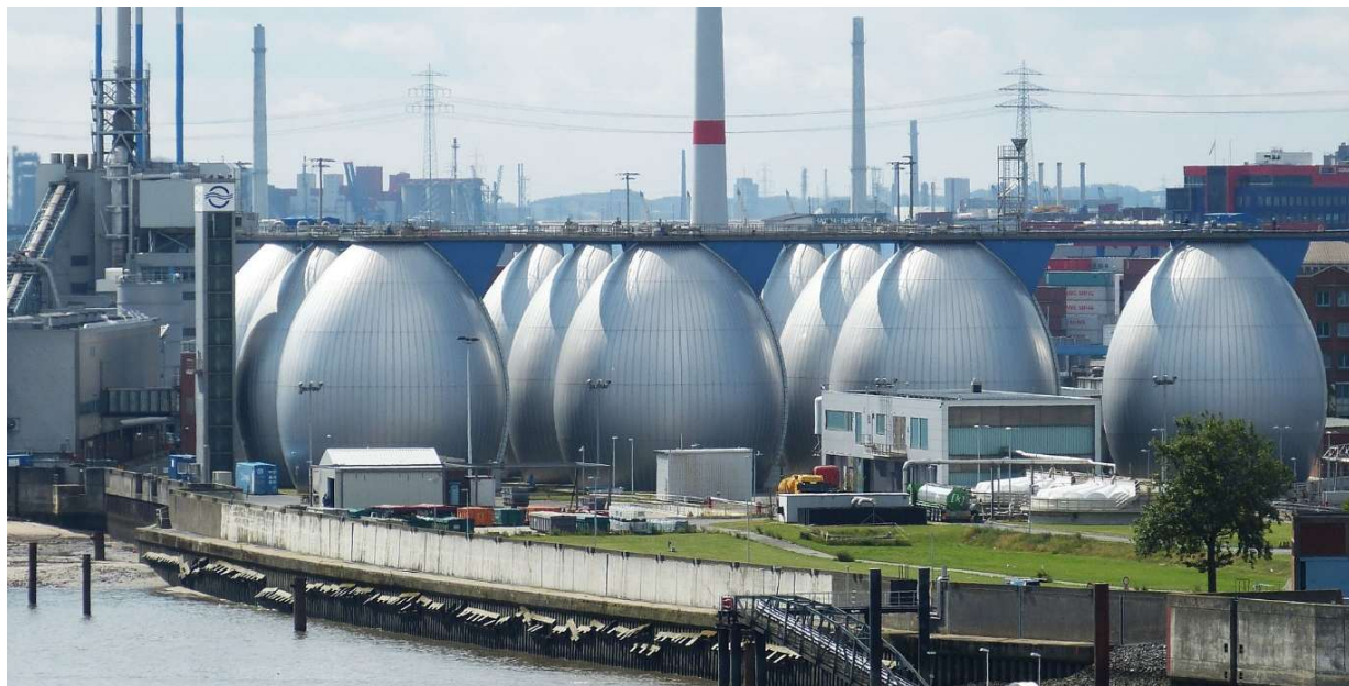
Klärgasanlage im Klärwerk Hamburg, am Hafen
