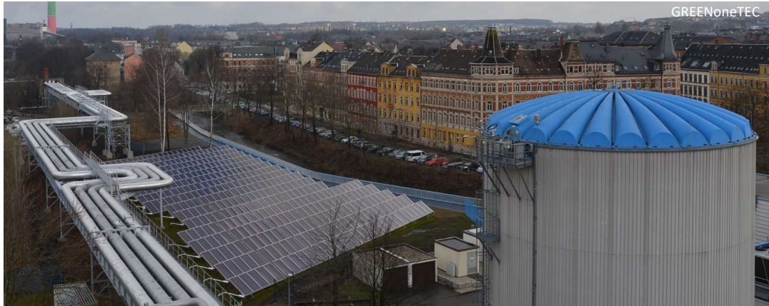
Chemnitz: 2.100 m 2 Kollektoren (im Bild: Teilfeld), 1000 m 3 Speicher
